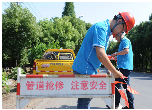
队伍在面对突发供水事故时，不但要在第一时间作出反应，及时做好抢修工作，同时必须保证现场安全文明施工、规范操作、信息畅通。
